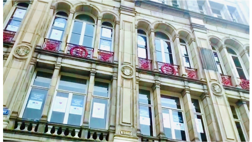
Figuur 5 Het pand in huidige staat
